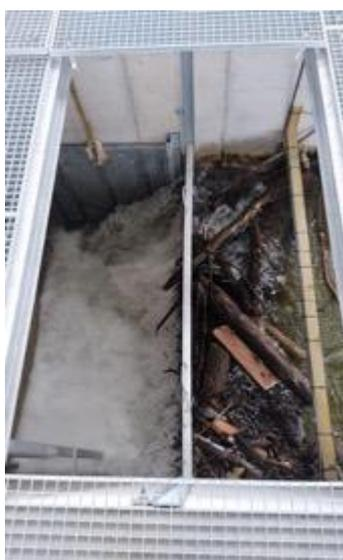
Le système de vanne du bypass s'est aussi avéré défectueux à cause d'une mauvaise conception et installation, l'ouverture de la vanne s'effectuait grâce au treuil de l'engin de dégrillage des turbines et la fermeture était réalisée manuellement en poussant la vanne vers le bas à l'aide d'une masse. Cette opération était à la fois longue et peu efficace pour les opérateurs (Profish et Luminus).
