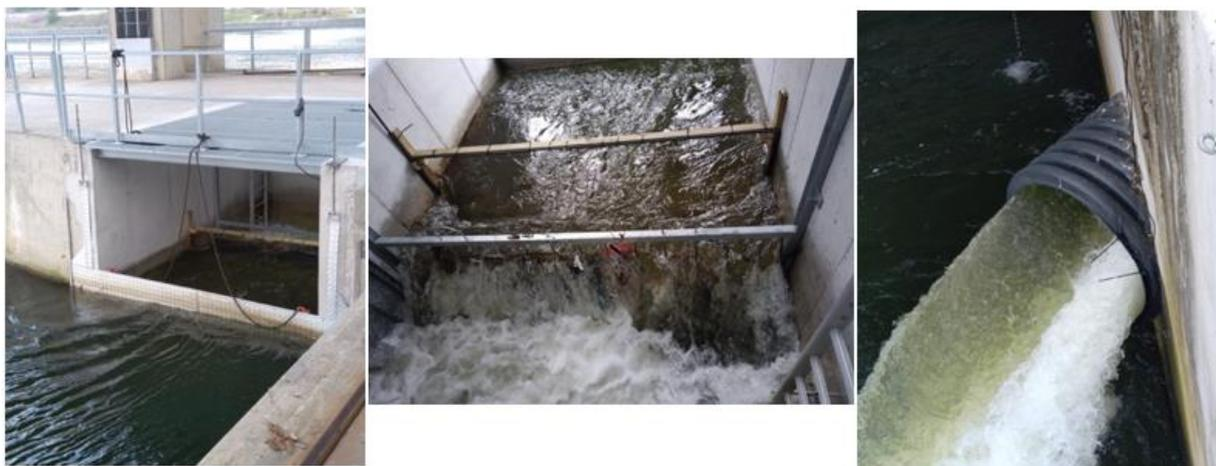
Figure 8 : De Gauche à droite : entrée du bypass en amont du plan de grilles des turbines, intérieur du bypass avec le plan de grille. L'antenne RFID a été installée sur le cadre en bois devant la grille sur toute la section du canal d'entrée, sortie du bypass en aval des turbines. L'antenne RFID a été fixée autour de la canalisation.
